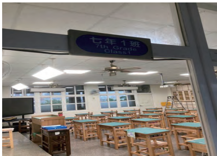
普通教室照明設備更新
