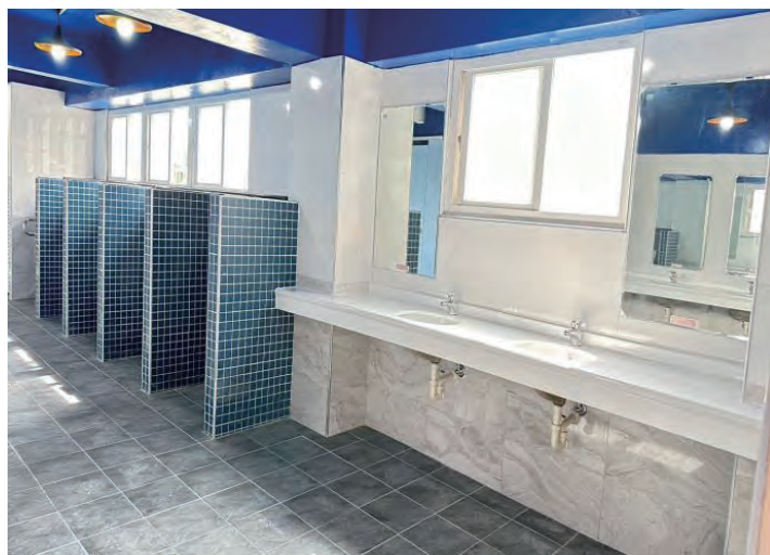
A2 棟廁所整修工程完工
