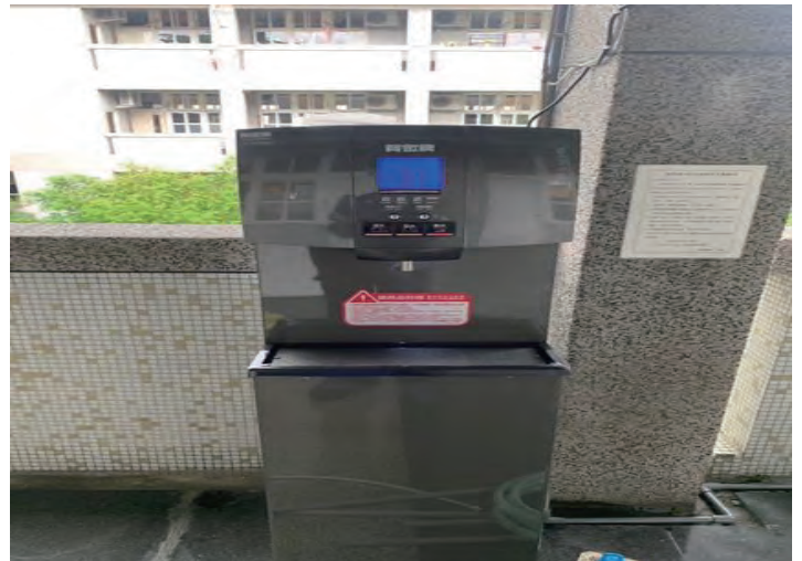
飲水機汰舊更新 (A1 棟 2F)
