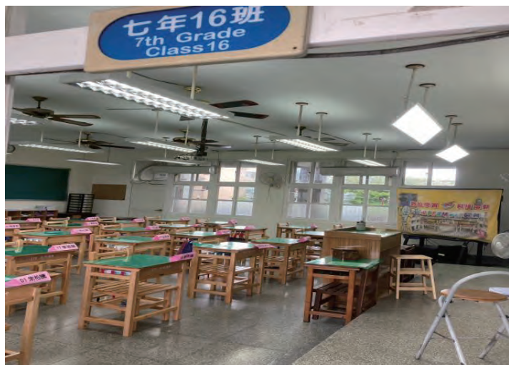
普通教室照明設備更新
