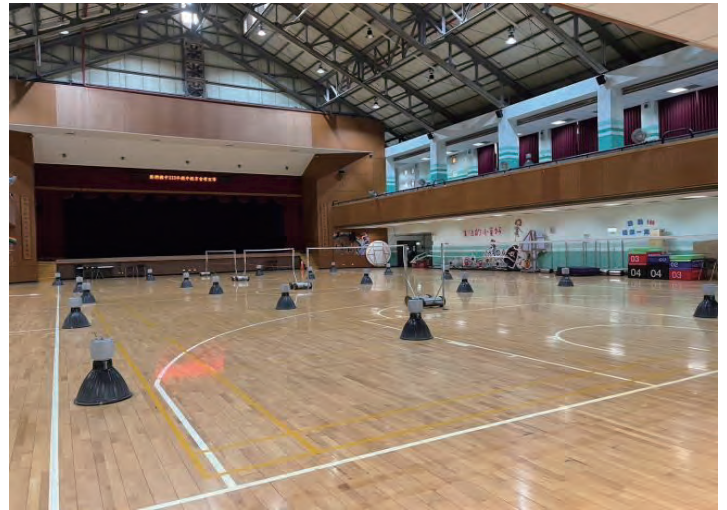
體育館照明設備更新
