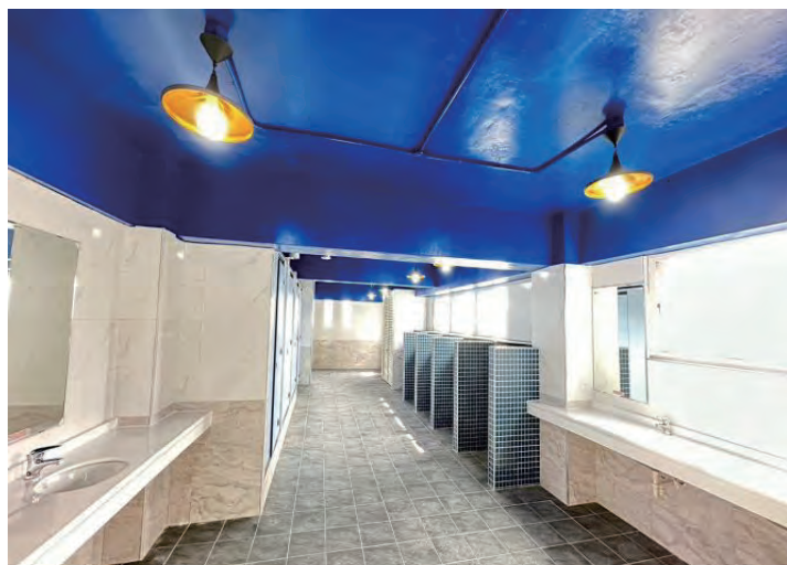
A2 棟廁所整修工程完工
