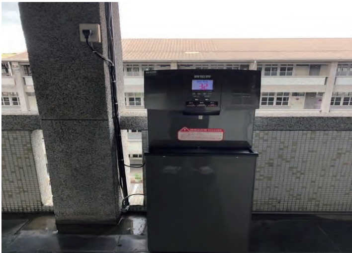
飲水機汰舊更新 (A2 棟 3F)
