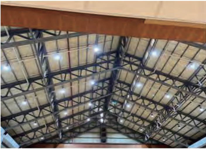
體育館照明設備更新
