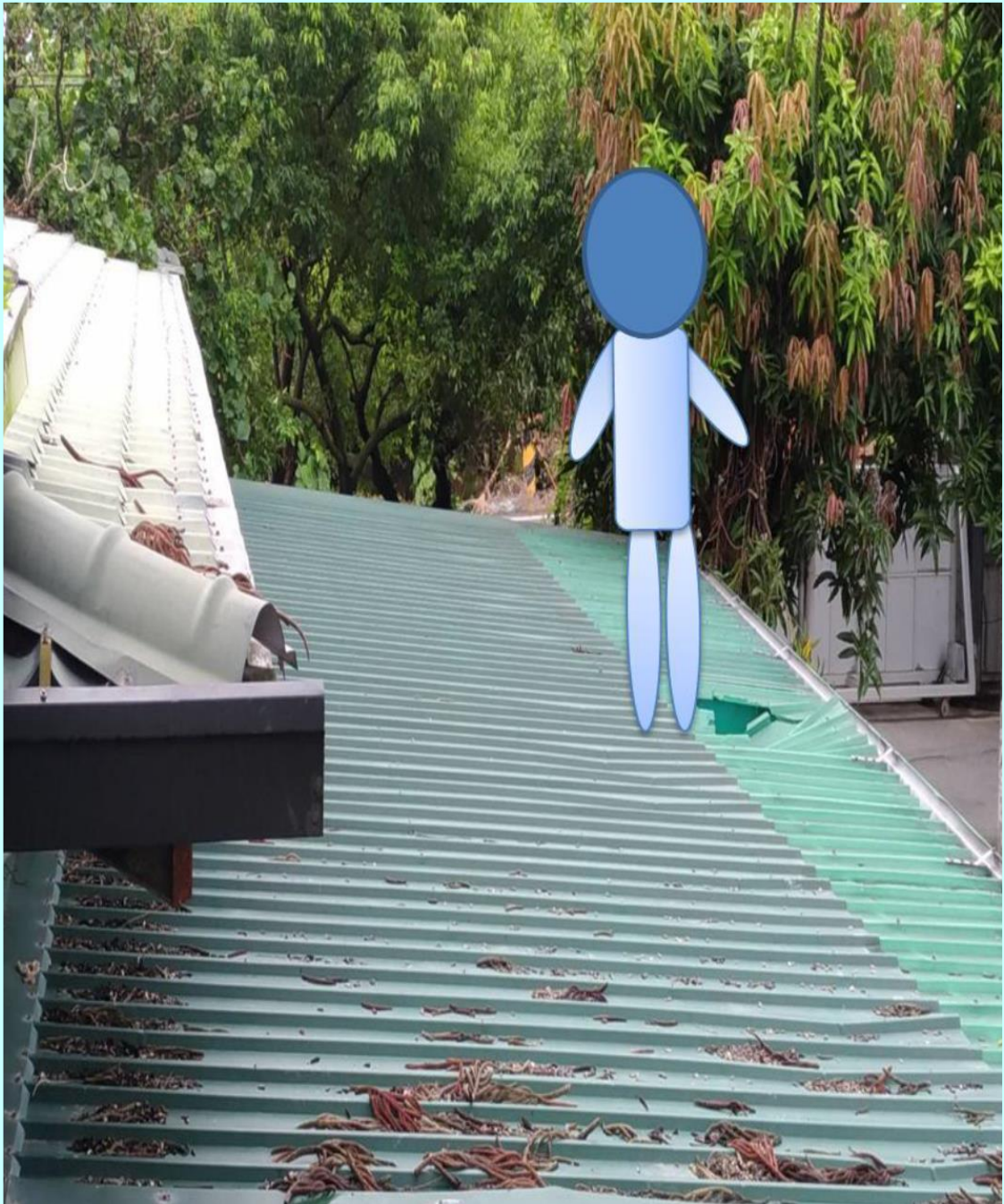
罹災者踏穿之塑膠採光罩破洞呈不規則形，長×寬尺寸約 90 公分×50 公分
